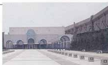
ゲートからエントランスまでのアプローチ
